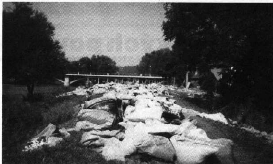
HRAZE NEPOMOHLY. Hraze z pytlů naplněných pískem stavěli Letovští marně. Lety nakonec byly jednou z nejvíce velkou vodou postižených obcí našeho regionu. Foto NN M. FRÝDL
