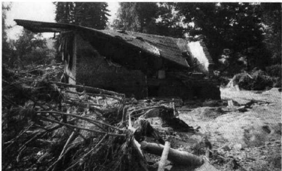
OBRAZ ZKÁZY. Když rozběsněná Berounka opadla, vypadalo to mnohde jako po bombardování. Tohle zhylo ze zděného rekreačního objektu na Ostrově v Zadní Třebaně. Foto NN M. FRÝDL
