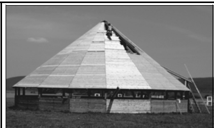
OPRAVA STŘECHY. První přívál nového sněhu na konci loňského roku způsobil propad vrchní části tzv. loňzovacího kruhu SK LUKE ve Skříplu. Po zimních měsících byl zvěšen sklon střechy. (rk) Foto J. Kozák
