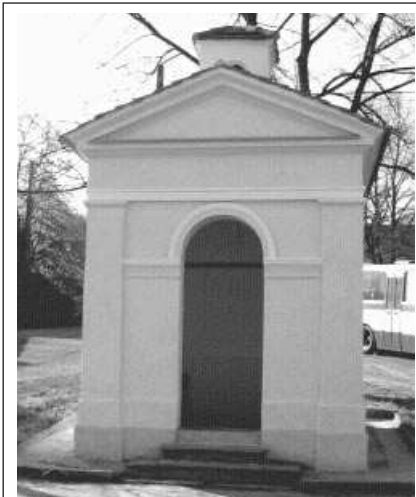
V novém kabátu oslaví 120. narozeniny kaple v Hodyni. „Oprava stála 60 000 korun,“ řekl NN zastupitel Skuhrova, kam Hodyně patří, Kácha. Foto NN J. KOZÁK
