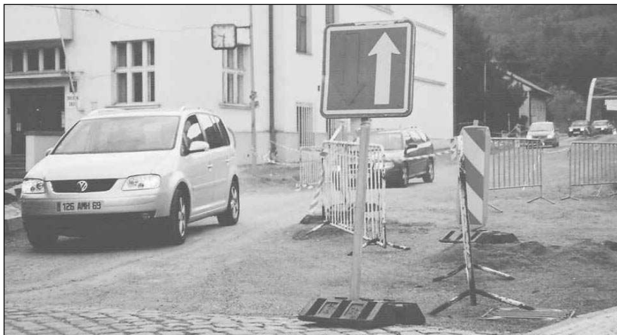
TĚŽKÝ ŽIVOT ŘIDIČŮ. V minulých dnech se opravovala silnice před dobřichovickým mostem. Další komplikace řidiče ještě čekají - v Dobřichovicích i Řevnicích. Foto NN M. FRÝDL
