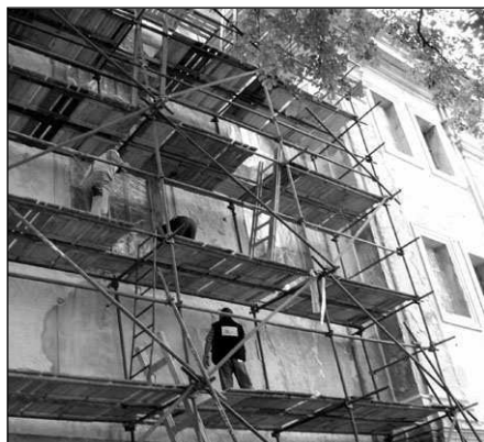
Osovský barokní kostel rocháží rozsáhlými úpravami. Nyní probíhá oprava vnějšího pláště budovy. Foto R. KOČOVÁ
