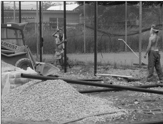
UŽ PRACUJÍ. Nové víceúčelové hřiště začali budovat Svinářští. Hotovo by chtěli mít v půlce července. Foto NN L. PALÍČKOVÁ
