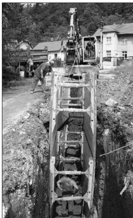
Kanalizace se v Srbsku pokládá až do šestimetrové hloubky. Foto Svatava BISKUPOVÁ
