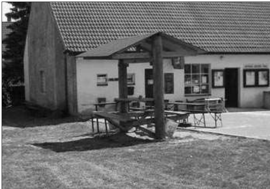
I v létě je kladen důraz na údržbu zelených ploch v obci. V budově na snímku právě probíhá komplexní oprava zdravotního střediska. Foto Bohumil STIBAL
