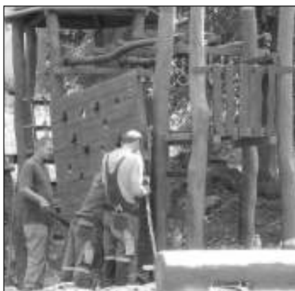
UŽ ROSTE. Dětské hřiště se začalo stavět v Řevnicích. Foto NN P. ŠVÉDOVÁ
