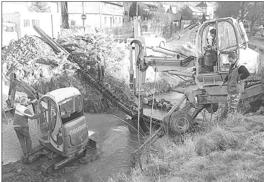
PŘEKLÁDALI KABEY. Rekonstrukce mostu začala překládkou kabelů.
