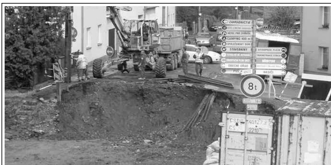
MOST ZMIZEL. Bez mostu na hlavní silnici směr Revnice bude až do léta Zadní Třeboň. Objížďka vede přes Svináře. Obyvatelům Zadní Třebaně vystaví obecní úřad na vyžádání povolenky pro průjezd do Revnic kolem Svinářského potoka. (pef)
