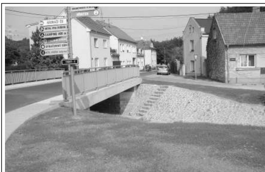
MĚSÍC V PROVOZU. Most přes Svinařský potok v Zadní Třebani je skoro měsíc v provozu. Jeho okolí už nepřipomíná staveniště, všude je upravený terén a plochy zarůstají vysetou travou. Obecní úřad zvažuje v budoucnu toto místo ještě zkrášlit.
