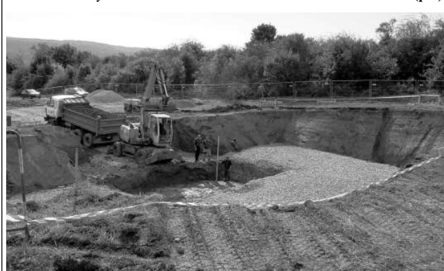
BRZY BUDE HOTOV. Obří vodojem, který v těchto dnech vyrůstá u Mořinky. Foto NN M. FRÝDL
