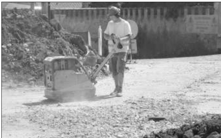
JDE TO RYCHLE. Výstavba vodovodu a kanalizace ve Všeradicích je v plném proudu.
