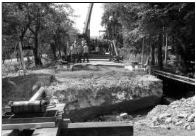
STAVĚLI VOJÁCI. Provizorní konstrukci mostu nad Bělečský potok »usazovali« vojáci.
