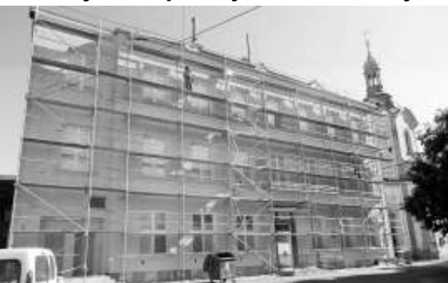
NOVÁ OMÍTKA. Od začátku prázdnin je zateplována jižní stěna ZŠ F. J. Režáče v Litni. Práce, včetně nové fasády, mají skončit do poloviny srpna. Tím bude završena první etapa zateplování, která byla zahájena východní stranou loni na podzim. Ema MALÁ, ZŠ Liteň Foto NN M. FRÝDL
