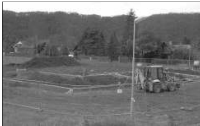
BUDOUCÍ ŠKOLKA. Staveniště, na kterém postupně vyroste hlásoňtřeboňská mateřská škola. Foto NN M. FRÝDL
