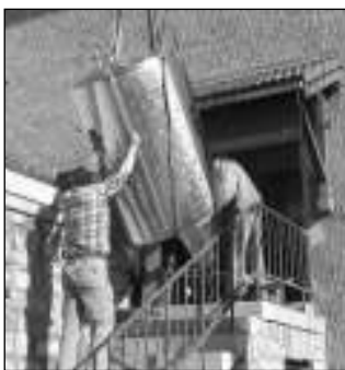
TANKY. Instalace nových vinařských tanků. Foto David CHOCHOLATÝ
