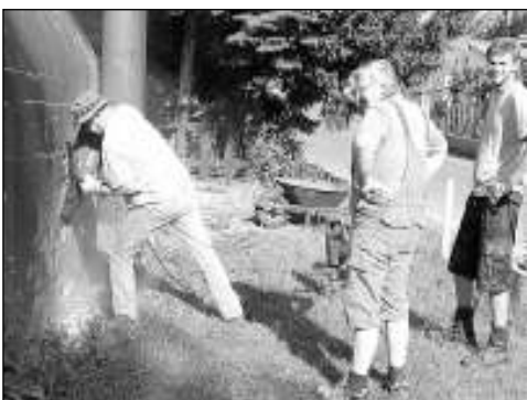
PŘI PRÁCI. Nadšenci, kteří se pustili do obnovy předválečného bunkru v Karlštejně. Foto Petr ŠTEMBERK
