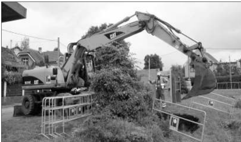
UŽ PRACUJÍ. Budování kanalizace v Zadní Třebaně už je v plném proudu.
