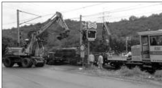
NEPROJEDETE. Do oprav hned několika železničních přejezdů se v těchto dnech pustili dělníci. Od 9. do 12. 8. neprojedete v Řevnicích k tamnímu kempu, od 9. do 11. 8. budou uzavřeny zadnotřebské přejezdy U Mlýna a Pod Chybou (na snímku). Foto NN M. FRÝDL
