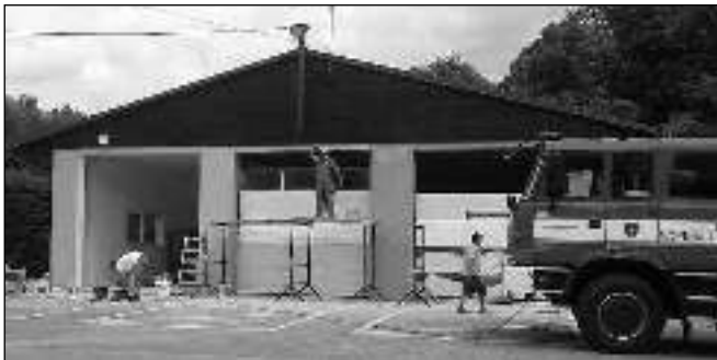
ZBROJNICE. Karlštejnská hasičská zbrojnice při rekonstrukci...
