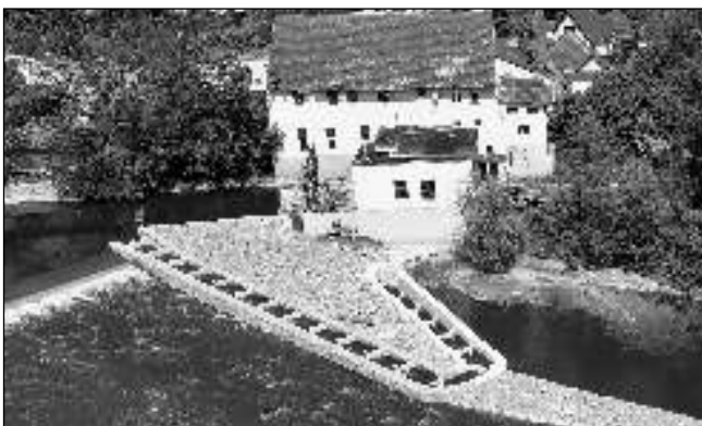
Z DRONU. Část rekonstruovaného jezu s rybním přechodem. Foto ARCHIV
