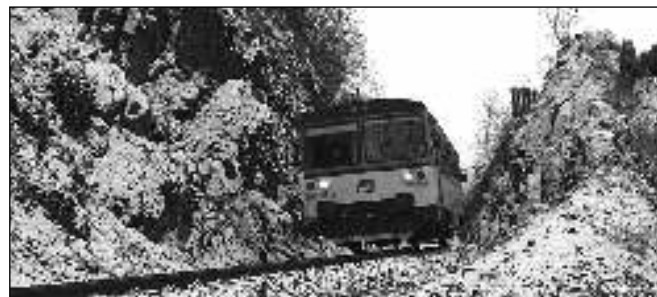
UŽ JEZDÍ. Dva měsíce trvala rozsáhlá rekonstrukce železniční trati Zadní Třeboň - Lochovice. Od 30. 11. už lokálka zase jezdí. Foto NN M. FRÝDL
