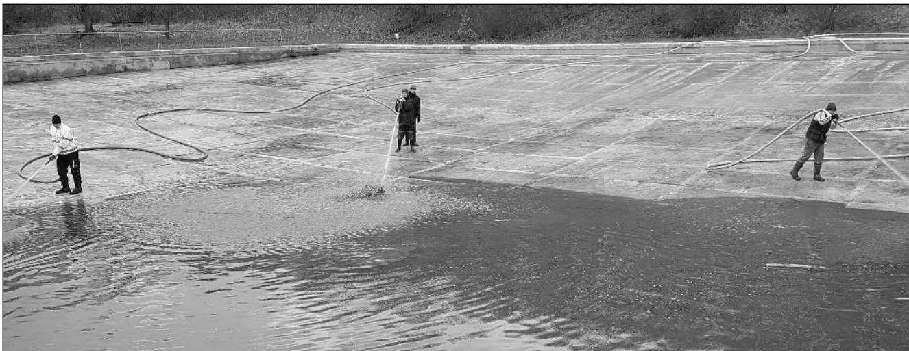
VYČISTILI NÁDRŽ. Všemradičtí dobrovolní hasiči při čištění místní požární nádrže.
