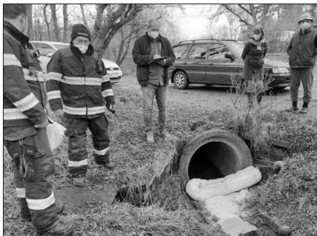
Zábrana, kterou hasiči instalovali na výtoku z Bělče. Foto Jiří VODIČKA
