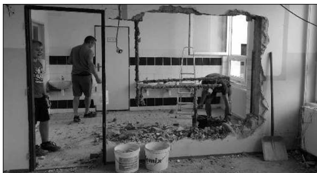
ŠKOLA V REKONSTRUKCI. O letních prázdninách se v zadnítreboňské málotřínce stěhovalo, vyklázalo, bouralo, aby se mohla naplno rozjet plánovaná rekonstrukce. Děti se tak mohou těšit na nové sociální zařízení a první nácti na zbrusu novou učebnu. Foto Kateřina MATĚJČKOVÁ
