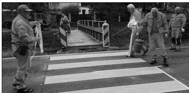
Osazování nové lávky v Zadní Třebani.
