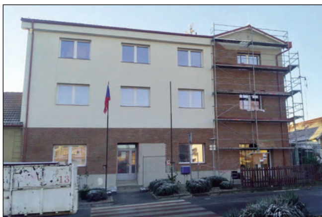
V NOVÉM KABÁTĚ. Liteňská radnice těsně před dokončením rekonstrukčních prací. Foto Filip KAŠTÁNEK
