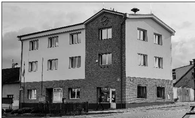
V NOVÉM KABÁTĚ. Liteňská radnice po dokončené rekonstrukci. Foto Filip KAŠTÁNEK
