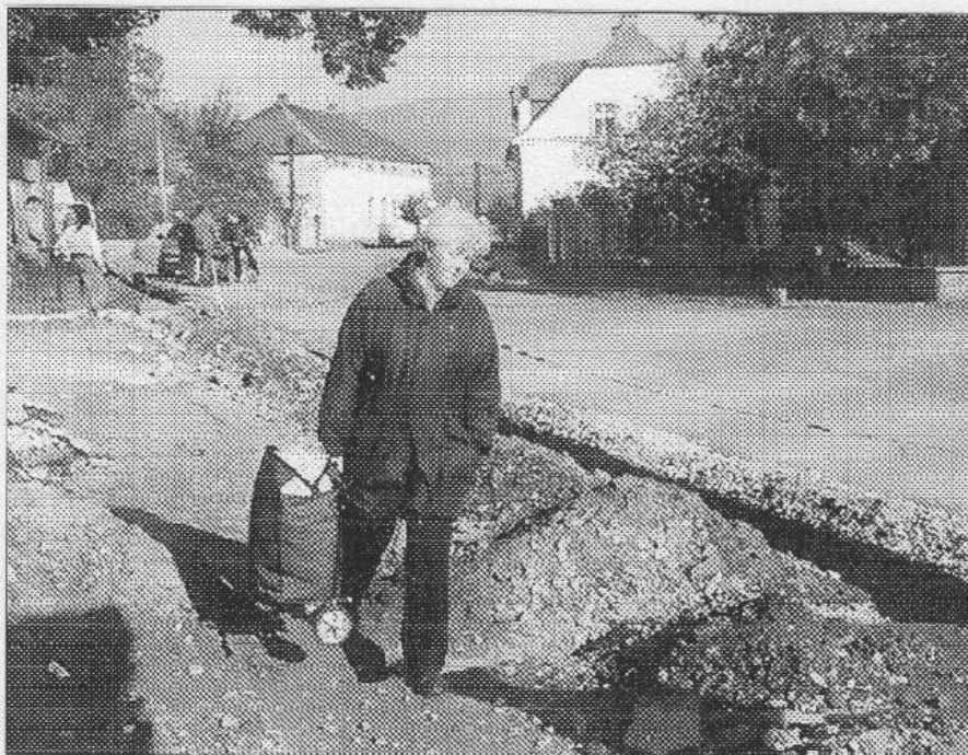
Pani překračuje poblíž zadno-třebaňské prodejny Jednota výkop, do něhož budou uloženy dráty. Budování nových telefonních rozvodů v naší obci je v plném proudu. Foto NN M. FRÝDÍ.
