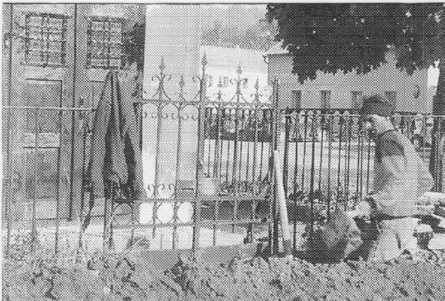
* Nejvíce konec roku v Zadní Třebani poznamenala výměna telefonních kabelů. Kopalo se i u místní kapličky, před nedávnem důkladně rekonstruované. Foto NN M. FRÝDL
