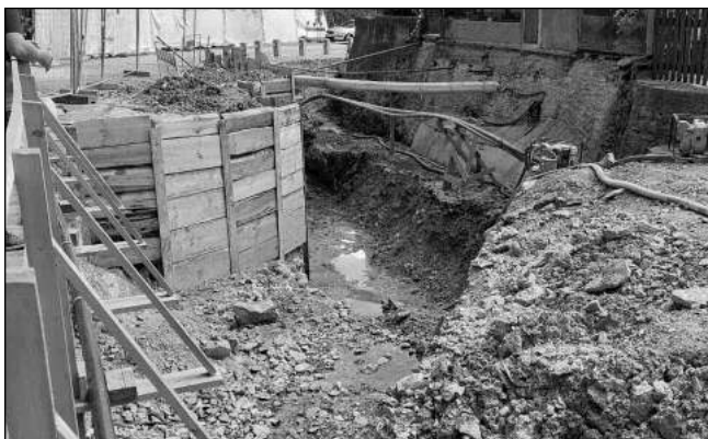
PODLE PLÁNU. Stavba mostu na silnici ke Dračí skále pokračuje podle harmonogramu. Foto Josef ČVANČARA
