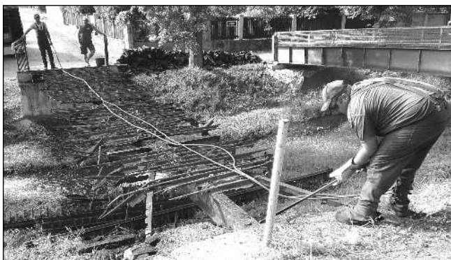
Dělníci při demontáži staré lávky přes Svinařský potok v Zadní Třebani. Nová má začít sloužit nejpozději v listopadu. Foto NN M. FRÝDL
