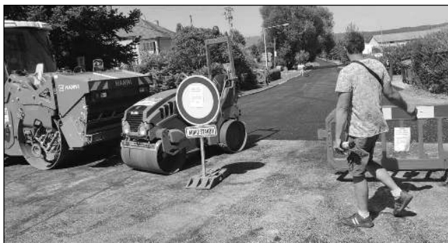
OPRAVENO. Jednou z opravovaných liteňských ulic byla také silnice od čerpací stanice směrem na Vlence a Karlštejn. Foto Filip KAŠTÁNEK
