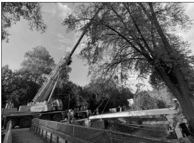
POMOHL JEŘÁB, Nová mostovka byla na své místo v Zadní Třebani usazena v pátek 7. října. Foto Markéta SIMANOVÁ ml.
