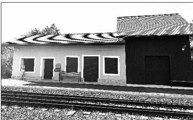
»NOVÉ« NÁDRAŽÍ. Železniční zastávka ve Všeradicích po letošní rekonstrukci. Foto Jaroslava HADŽIOSMANOVIČ
