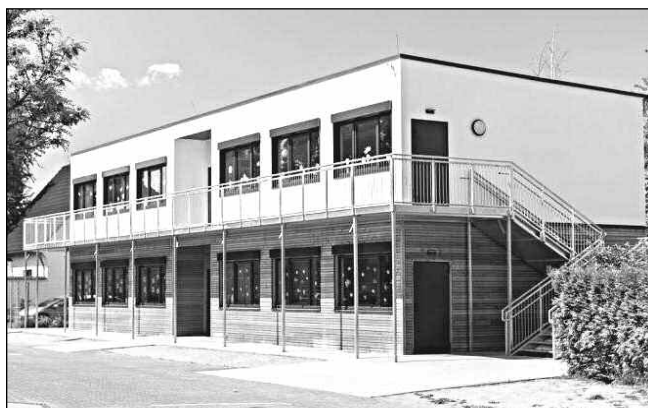
Z KONTEJNERŮ. Výstavba z kontejnerů je v současné době často využívána. Budují se z nich i školy. Ilustrační foto ARCHIV
