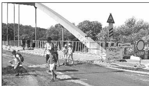
OPRAVENO. Silnice od karlštejského mostu do Litně už je opravená a průjezdná.
