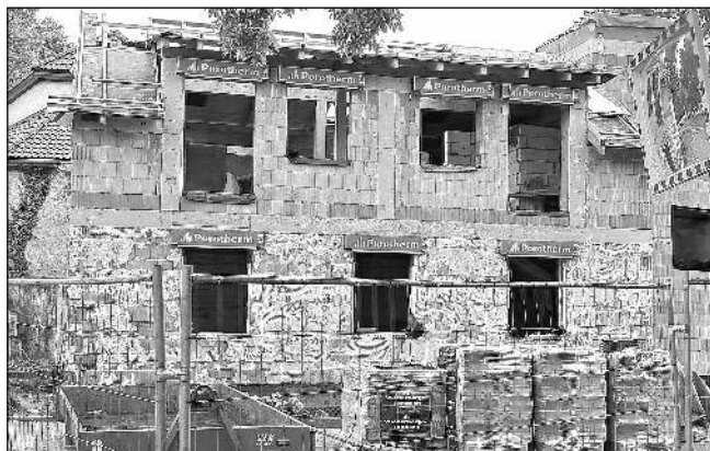
Stav rekonstrukce letovské knihovny k 6. září.
