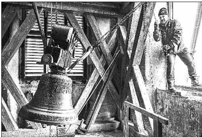
VE ZVONICI. Instalování nových řevnických zvonů Marie a Anežky do zvonice místního kostela sv. Mořice.
