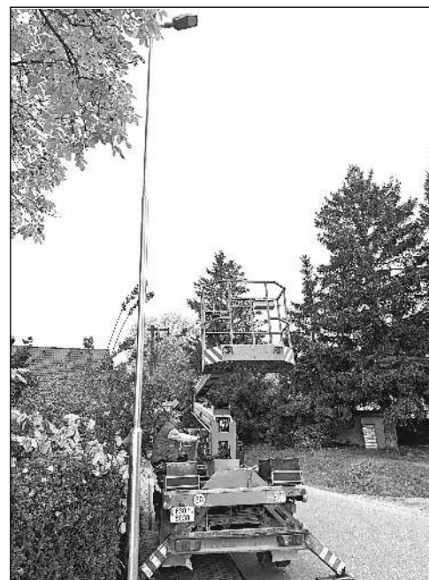
NOVÉ LAMPY. Instalace nového veřejného osvětlení ve Všeradicích. Foto Jaroslava HADŽIOSMANOVIČ
