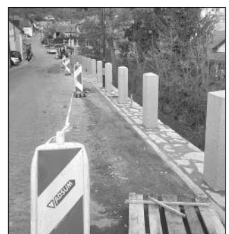
Opěrná zeď na pěší zóně je téměř hotová.
