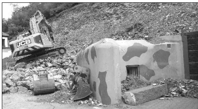
Bagr se »zakousl« do svahu vedle karlštejnského penzionu Bunkr. »Majitel penzionu dělá přístavbu s restaurací. »Ropík«, který byl součástí předválečného opevnění Československé republiky, zůstane uvnitř a má v něm být wellness,« uvedl starosta Karlštejna Josef Čvančara. Foto NN M. FRÝDL
