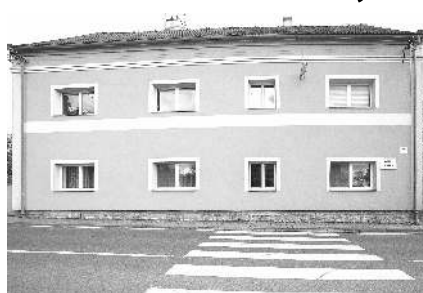
PŘED OBNOVOU. Školní jídelna v Suchomastech. Foto Filip JUNEK
